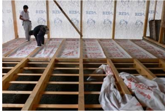
断熱材受け材の設置
