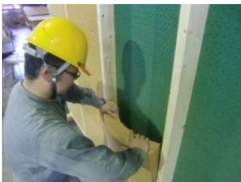
片側面を柱に軽く押し付けながらおさめる(曲げると入れ易い)
