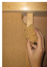
断熱欠損部は端材で埋める
