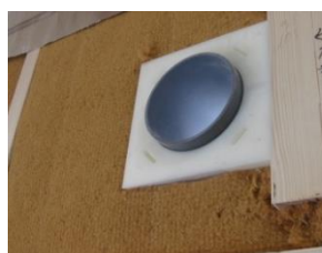
プラスチック系成形品を用いた場合の施工例 (防湿層施工前)
