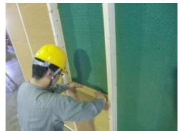
上から下に押し付け水平にし、下部に隙間ができないようにする
