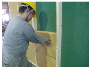
壁面に押しつけ、歪みや凹凸をなくす
