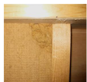
断熱欠損部は端材で埋める
