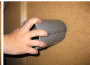
④パイプをねじ込む ※隙間などには端材を詰める
